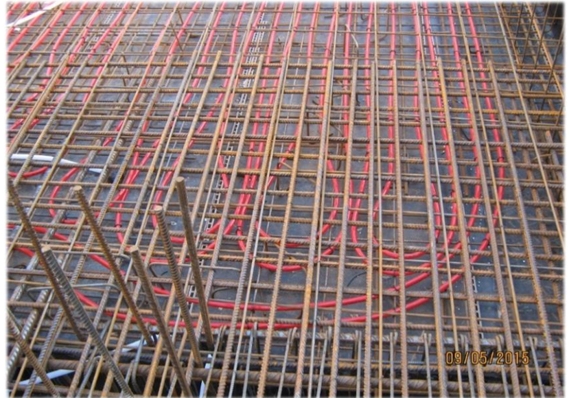
Темперирание на бетонната плоча
